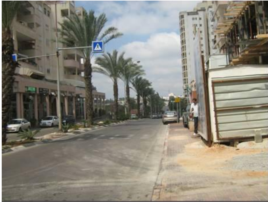
איור 1.6. מעבר החצייה ברחוב סוקולוב, הוד השרון, לפני ביצוע ההגבהה.
