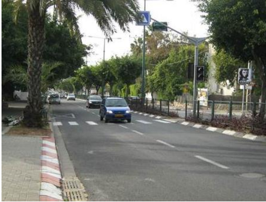
איור 1.12 מעבר החצייה ברח' הרב קוק צומת בן סרוק, הרצליה, לפני ביצוע ההגבהה.
