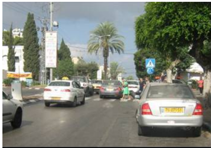
איור 4.15. צומת ויצמן-רוטשילד בחדרה: רצוי להצר גישה חד-נתיבית למעגל.
