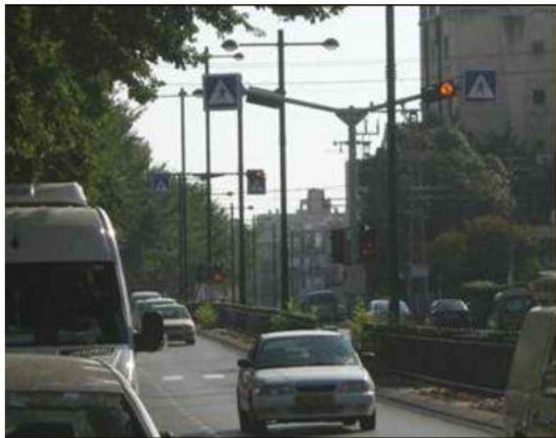
איור 5.2. רחוב פתח תקווה בנתניה: הבלטת מעברי חצייה באמצעות תמרורים עליים מאירים ומוארים ופנסים מהבהבים עליים וצדיים.
