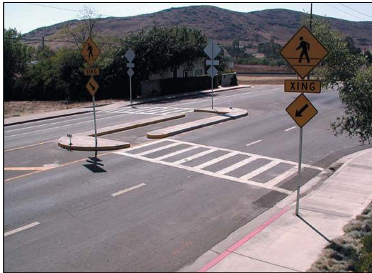
איור א.2. אי מפלט עם דרוג למעבר חצייה - הדרוג מפנה את הולך הרגל אל מול התנועה (מקור Harkey and Zegeer, 2004)
