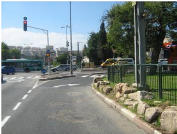
איור 4.7. צומת שלום עליכם-טרומפלדור בחיפה: רצוי להעתיק מעקה הולכי רגל אשר מפריע לנראות בין נהגים לבין הולכי רגל המתכוננים לחצות מכון המדרכה אל אי התנועה המשולש.
