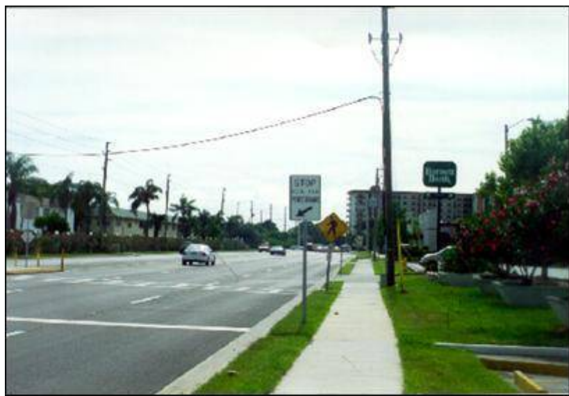
איור 5.10. פס עצירה מקדים ושלט מסביר, לפני מעבר חצייה בדרך רב-נתיבית (קנדה).
