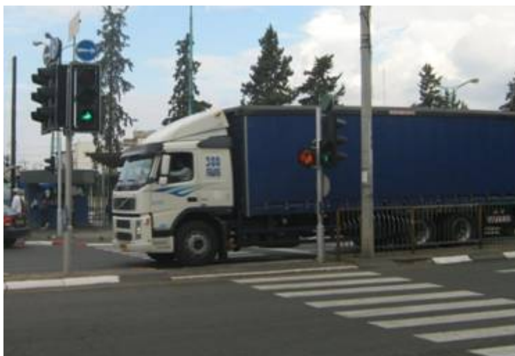
איור 4.21. צומת אורלוב-בר כוכבא בפתח תקווה: מופע משותף לרכב הפונה ימינה ולהולכי רגל עם מהבהב מותנה.
